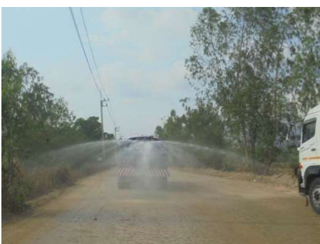
รูปที่ 2-21: รถบรรทุกน้ำฉีดพรมน้ำบริเวณ เส้นทางลำเลียงขนส่งแร่
